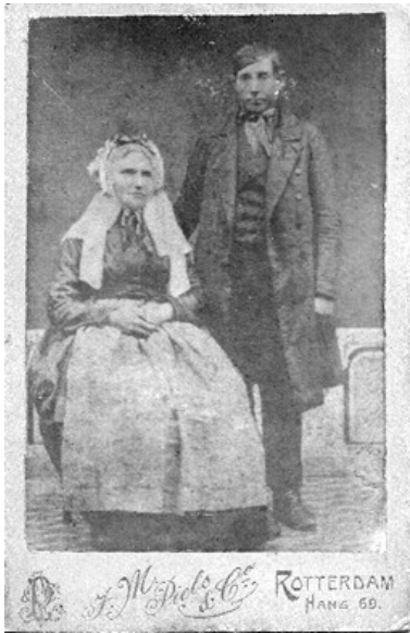
Bastiaan Stok en Klaasje van der Griendt
