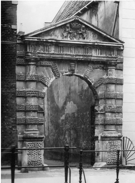
Utrecht, Hofpoort aan de Nieuwegracht, 1903, coll. HUA, cat. nr. 80562
