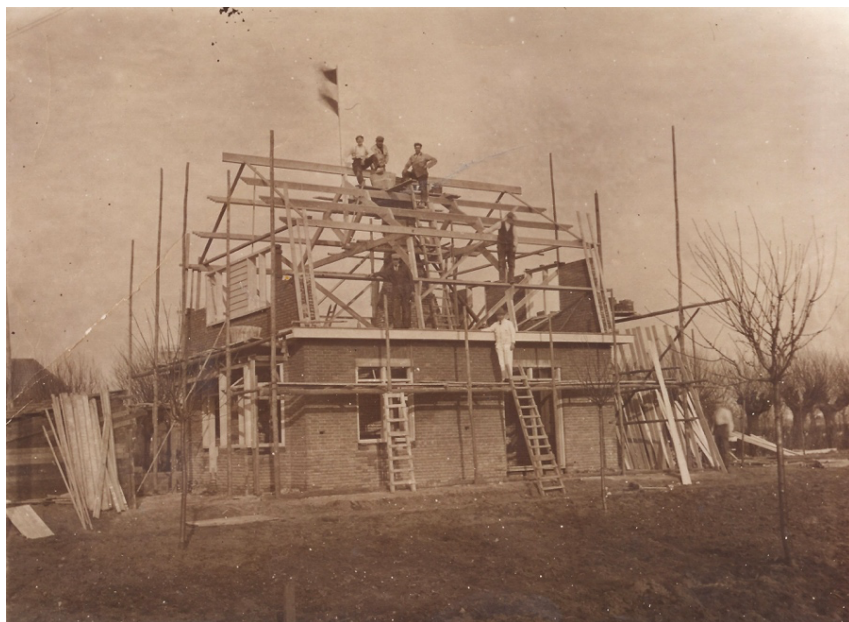
Afb. 1. Nijburgse straat 55 Randwijk in aanbouw.
