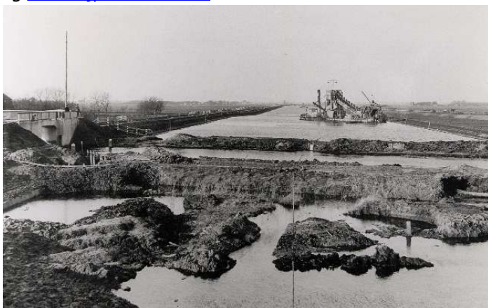
Het kanaal Stolpen-Schagen 'passeert' op 13 januari 1936 de toen nog intacte Groote Sloot Bron: De Canon van Zijpe
