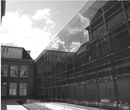
Rechts de glazen gevel van het nieuwe depot.
