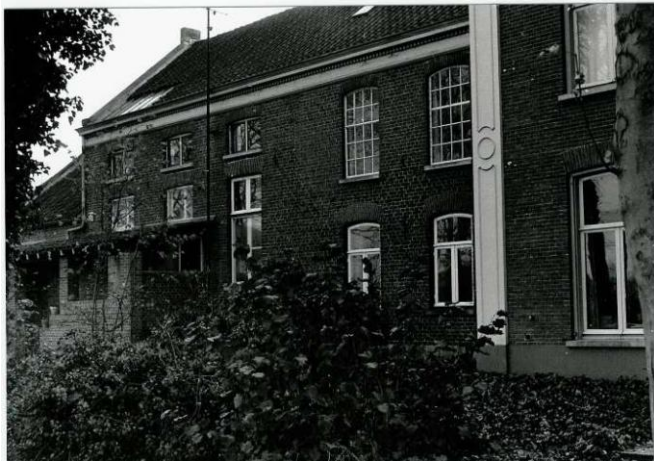
Weverij van Jacob Tirion, Stationstraat 1 in Nuenen, bron 'Beeldbank Heemkundekring De Drijehornick'
