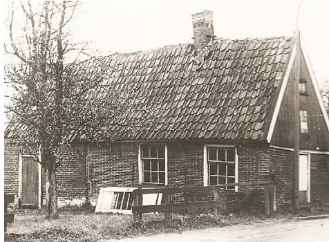
Keern 137, Hoorn. Tot 1972 in gebruik als opslag
