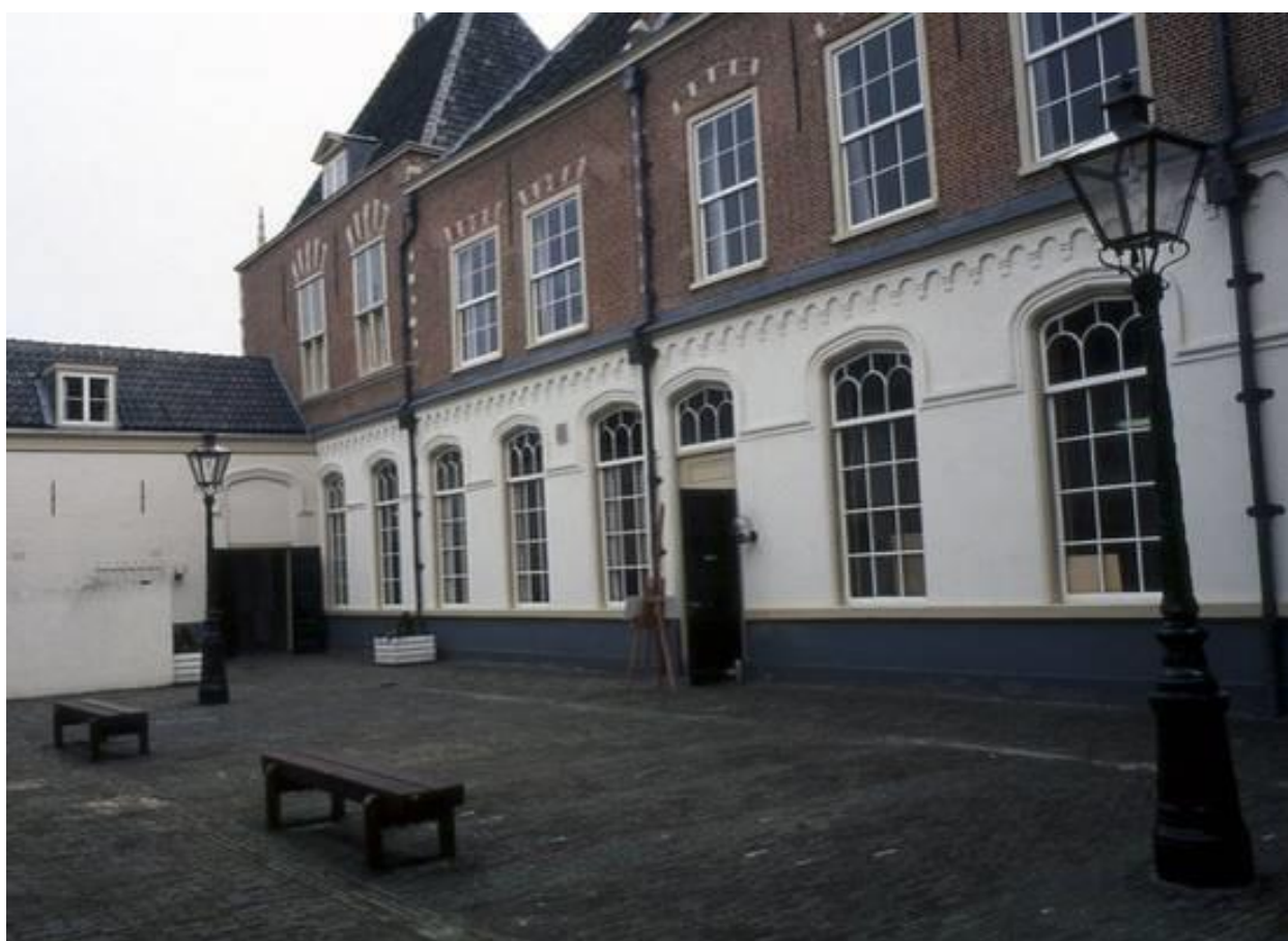
Oude schoolgebouw met vroegere schoolplein. Pieterskerkgracht 9
