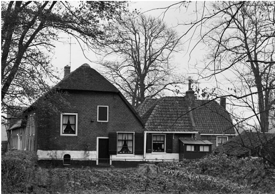
het linker voorhuis was de voormalige schuilkerk, 2 e Doodweg Vogelenzang
