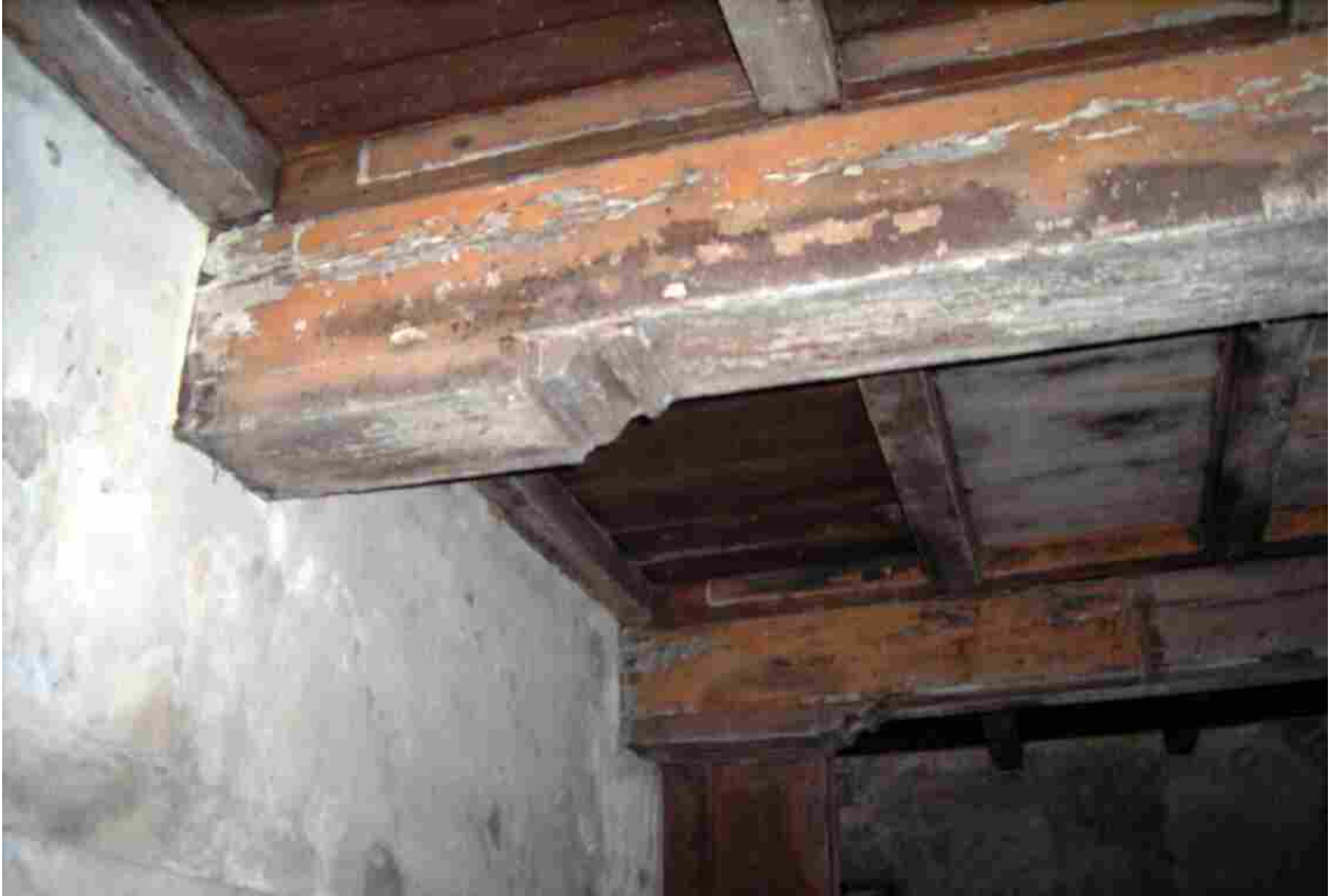
Balkconstructie afkomstig uit het gesloopte Herenhuis van het Hof Grijpskerke (17e eeuw). Na de herbouw is een deel van het materiaal hergebruikt in een huisje naast de in circa 1930 herbouwde boerenwoning.
