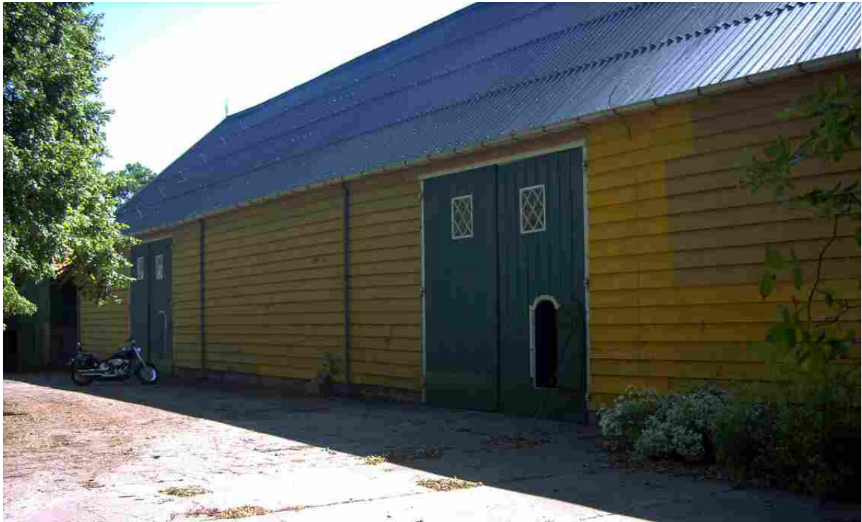
Grote schuur van het Hof Grijpskerke te Biggekerke. Het rietendak is na de Tweede Wereldoorlog vervangen door een nieuw dak. De schuur is uit 1894.
