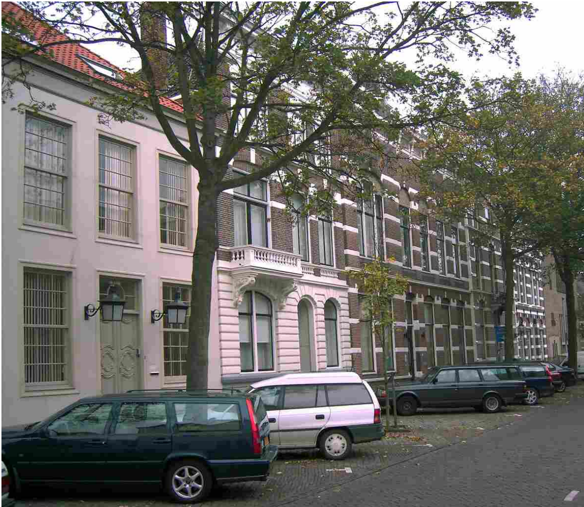
De rij herenhuizen welke rond 1890 in electische stijl werden gebouwd op de plaats waar vroeger de Noordmonster of Oude kerk stond. Onder het op de foto zichtbare wegdek van het Hofplein werden tijdens rioleringswerkzaamheden de fundamenten gevonden van de Noordmonster alsmede een grafkelder. Het zuidtransept van de kerk lag ongeveer op de plaats waar nu de huizen staan. Daar bevond zich oorspronkelijk het graf van Jacob van Grypskercke en zijn vrouw Sara Buydens.
